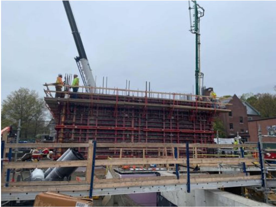
Concrete pour, Core AB.
