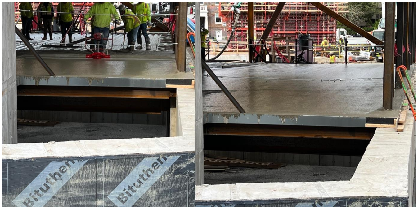
Concrete pour at Deck Slab C1
