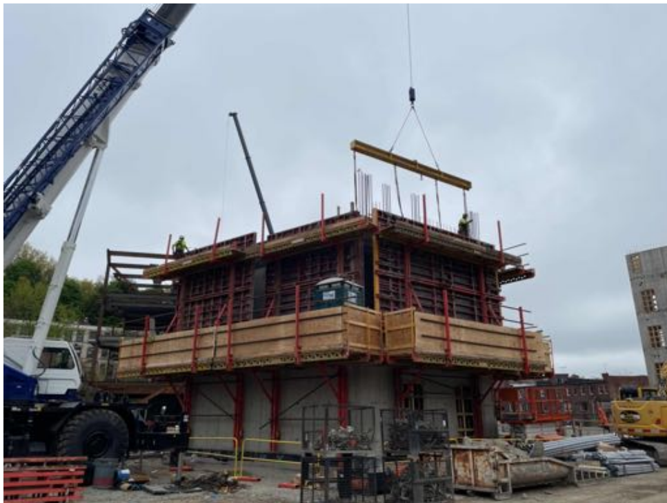
Setting rebar, Core AB.
