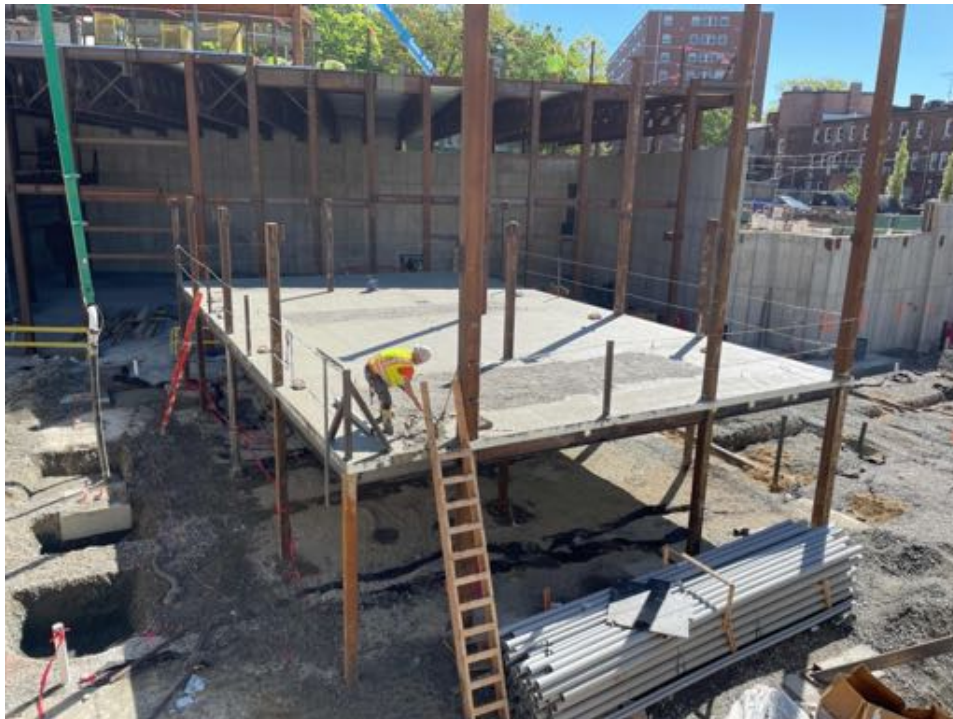
Mezzanine slab pour.
